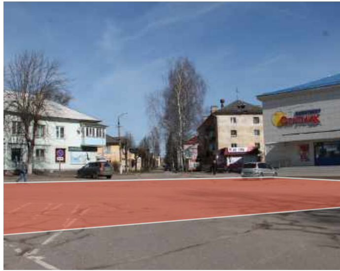
1 Отсутствие перехода в месте интенсивного движения пешеходов
