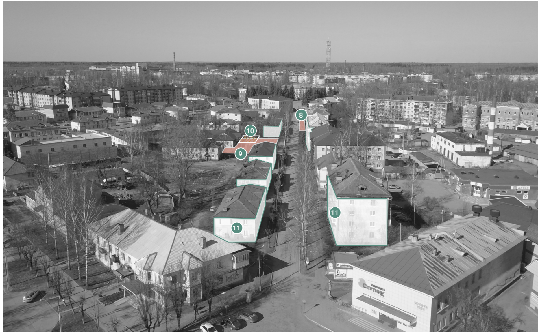
11 Ветхие фасады на улице Горького
