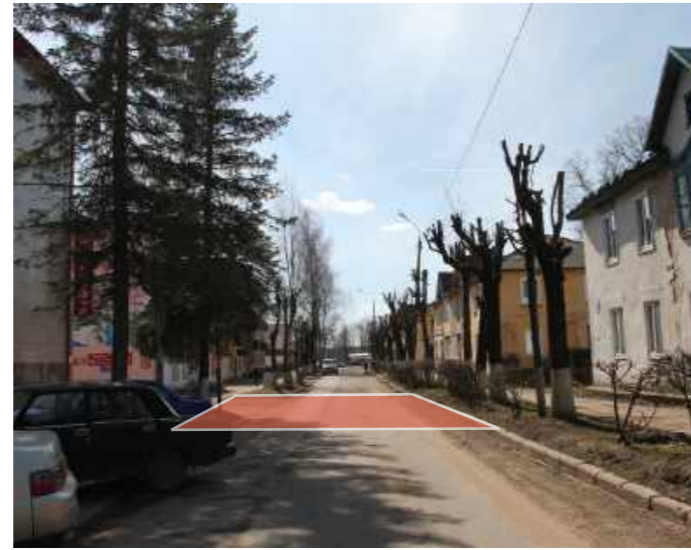
2 Отсутствие перехода в месте интенсивного движения пешеходов
