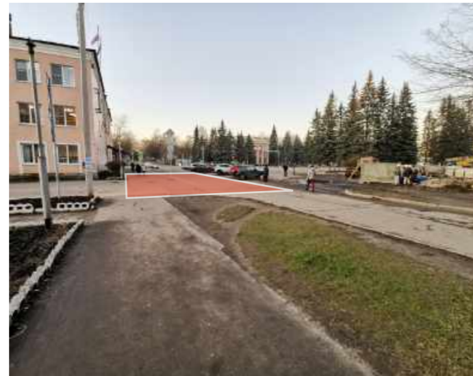
6 Отсутствие перехода в месте интенсивного движения пешеходов
