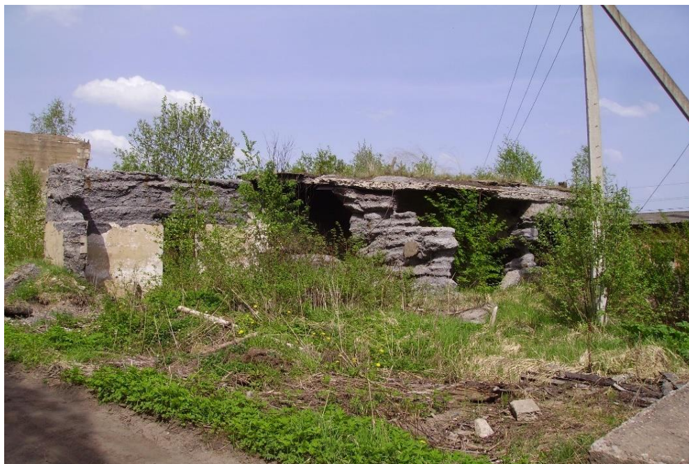
Рис. Б.1.2 – Здание вентиляторной
