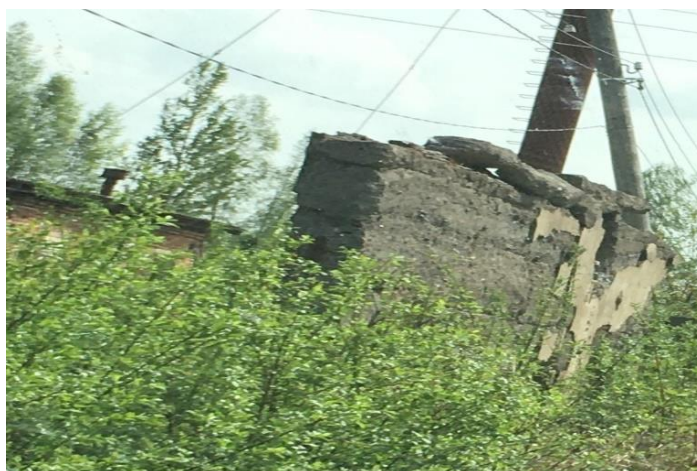
Рис. Б.1.1 – Стена машинного здания
