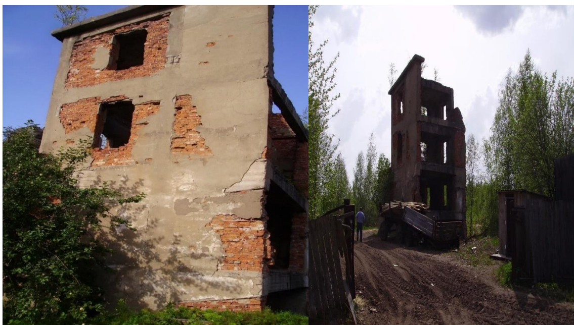
Рис. Б.2.2 – Надшахтное здание главного ствола
