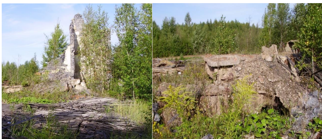
Рис.Б.2.4 – Здание котельной
