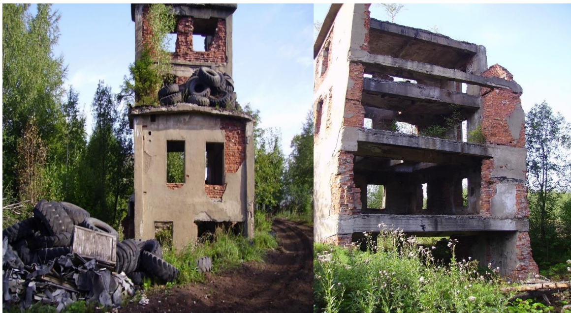
Рис. Б.2.1 – Надшахтное здание главного ствола
