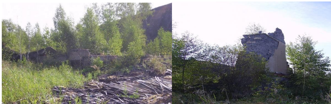
Рис.Б.2.3 – Здание котельной
