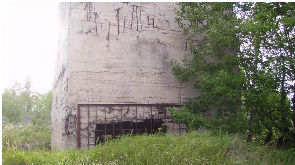
Рис. Б.1.3 – Надшахтное здание вспомогательного ствола
